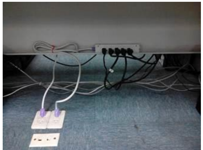
捨棄舊有資訊座，網路線直接接到交換器
